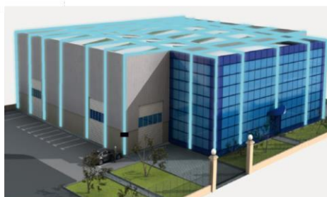
Edificio protegido mediante sistema de malla
